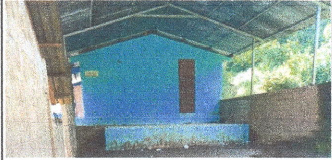
Foto 2: Sustitución de lámina, por lámina troquelada en salón
